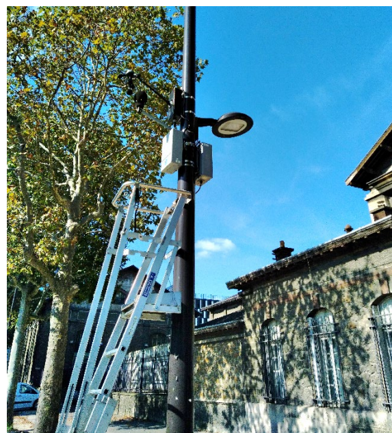
Figure 3 : Implantation des matériels au niveau du 32 boulevard Berthier à Paris.
